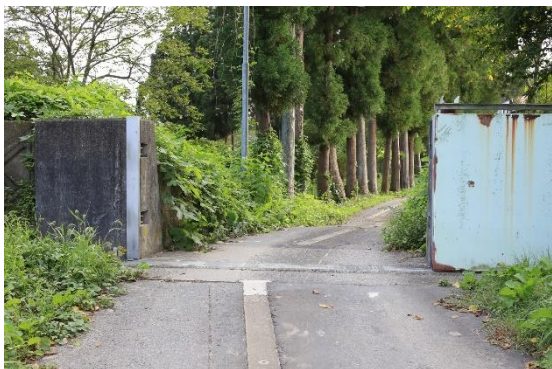
写真 3 町営駐車場最寄りの可動式防水壁
