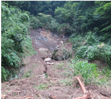
写真-4 斜面崩壊 (②)
